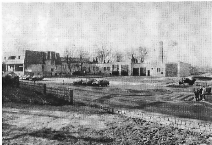
...i po zakończeniu robót
